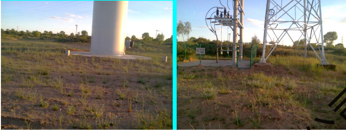
风机周边植被恢复情况
